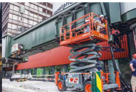
06.12.17 Passerelle d'embarquement Une passerelle d'embarquement originale de l'aéroport de Zurich relie le bâtiment d'accueil et la Halle de l'Aviation.
