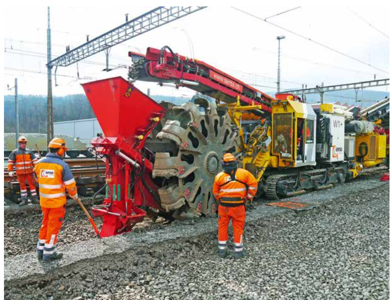
Déblaiement de vieux ballast avec le système W+.
