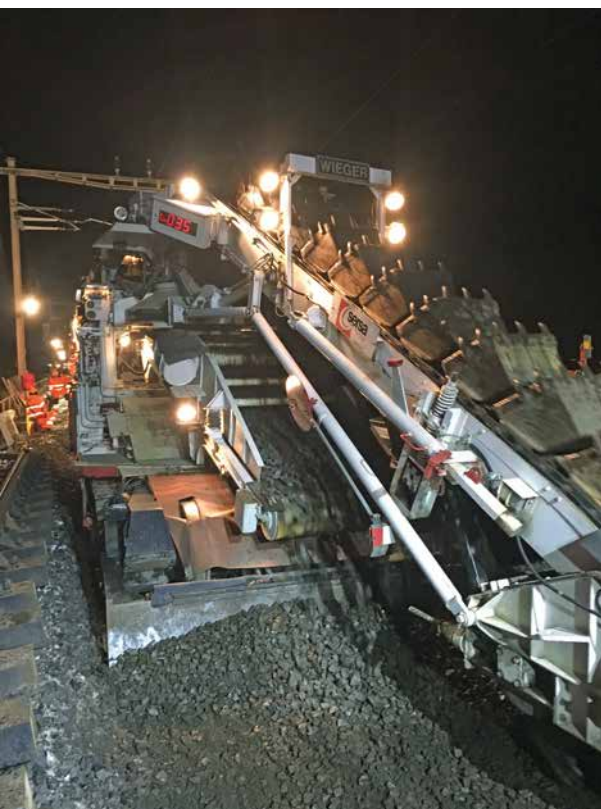
Dernière utilisation de la machine de nettoyage de ballast «Wieger», exposée désormais dans la Halle du Transport Ferroviaire.
