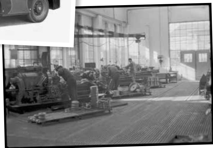
Aperçu de l'atelier d'Oehler à Aarau, vers 1960.
