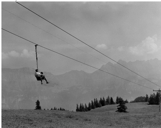
Kombilift von Oehler für die Bergbahnen Flumserberg. Betrieb im Sommer mit Sesseln und im Winter als Schlepplift mit Bügeln (VA-61821).
